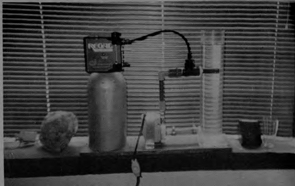
Equipo de Gas Cloro, instalado para su demostración
