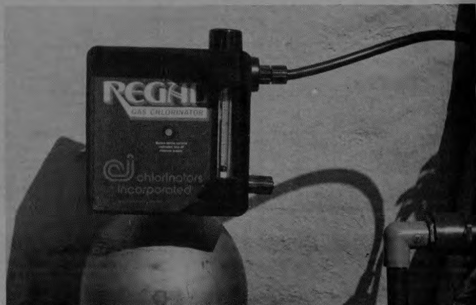
Equipo de Gas Cloro Regal
